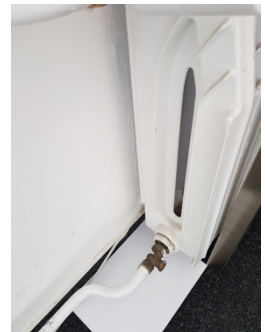
Bild 4: Rücklaufverschraubung
