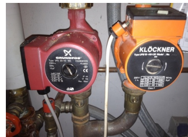
Heizungspumpen
