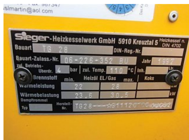
Typenschild Heizkessel
