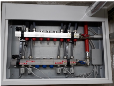
geöffneter Verteiler
